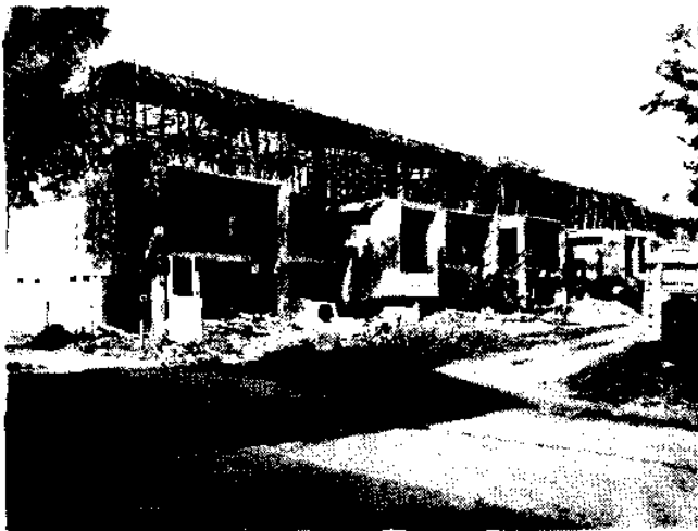
Het in aanbouw zijnde Internaat annex Lagere school van de S.I.V. aan de Grote Combeweg.
